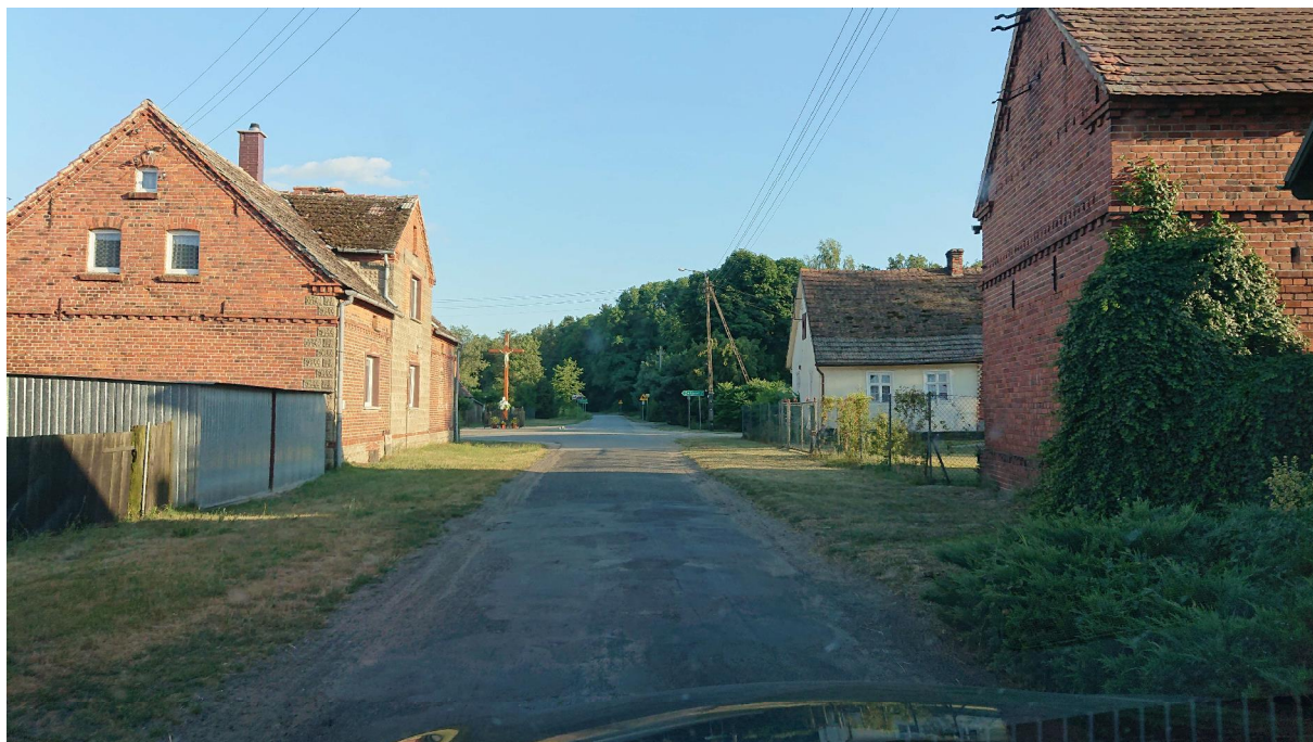
Fot. Nr 1 początkowy odcinek drogi od strony południowej ( zawyżone pobocza gruntowe )
