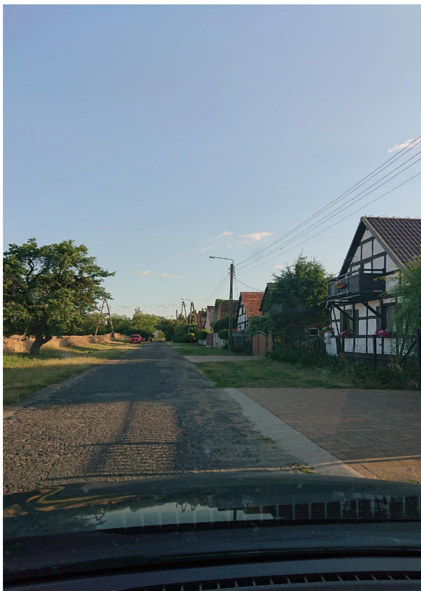
Fot. Nr 6 wykruszenia i spękania istniejącej nawierzchni i wyniesiony zjazd z kostki betonowej .
