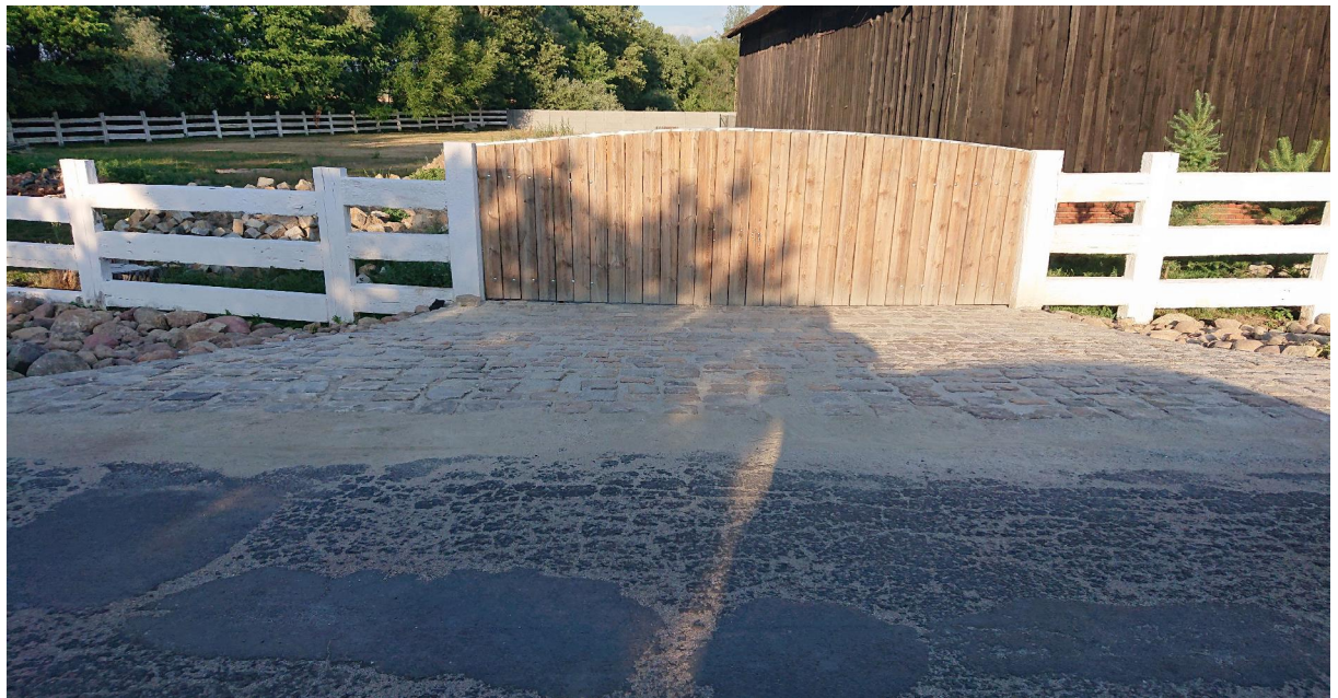
Fot. Nr 4 spękania i wykruszenia istniejącej (nawierzchni zjazd z kostki kamiennej) .
